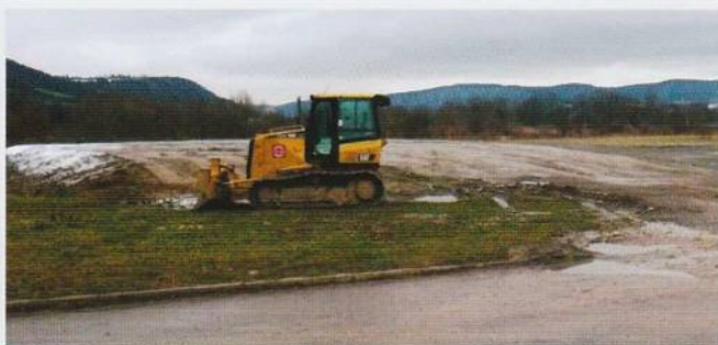
Erdaufschüttungen »Am Oelste«
