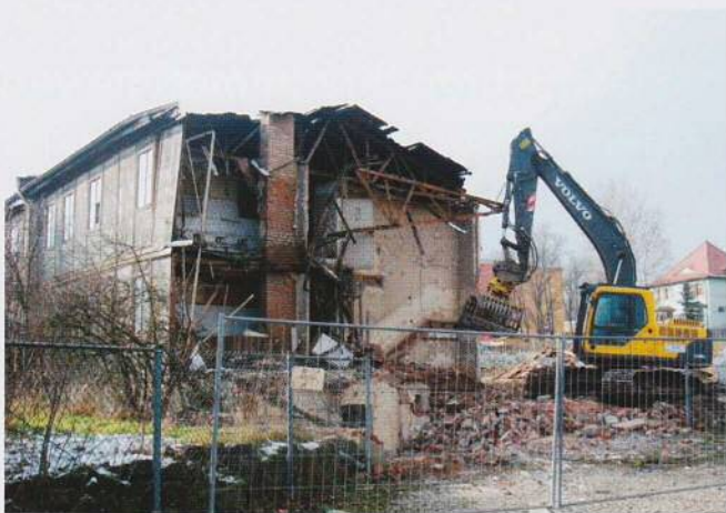
Abriss der ersten Studentenbaracken
